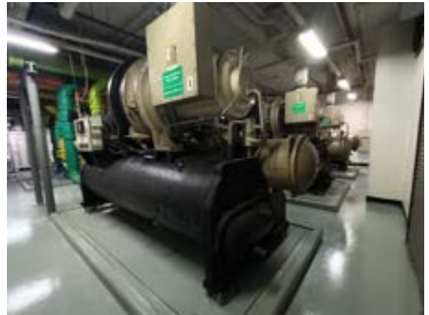
สภาพงานระบบปรับอากาศ (Chiller)
