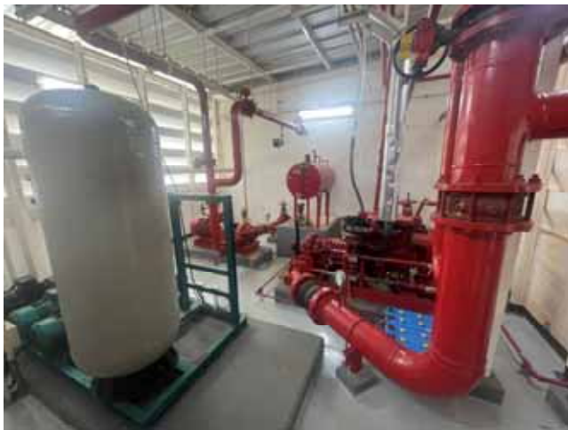
สภาพงานระบบป้องกันอัคคีภัย (Fire Pump)
