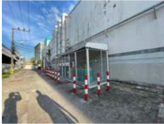
สภาพงานระบบภายนอกอาคาร-ห้องเก็บแก๊ส (Gas Station)
