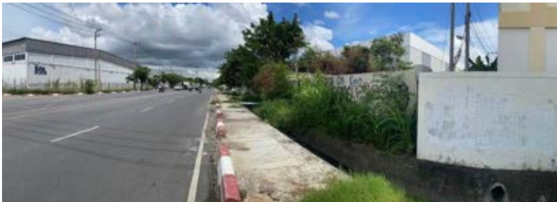
จุดถ่ายภาพที่ 5 : สภาพถนนนคร 4 ถนนผ่านด้านหลังทรัพย์สินที่ประเมินมูลค่า
