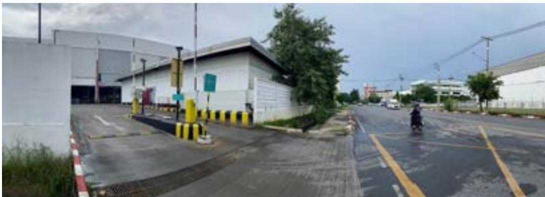
จุดถ่ายภาพที่ 6 : สภาพถนนนคร 4 ถนนผ่านด้านหลังทรัพย์สินที่ประเมินมูลค่า
