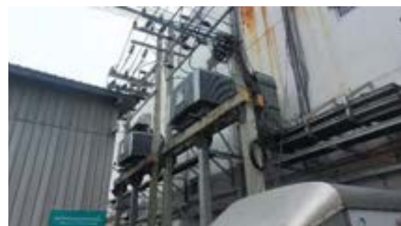
สภาพทั่วไปงานระบบอาคาร หม้อแปลงไฟฟ้า 1600 KV
