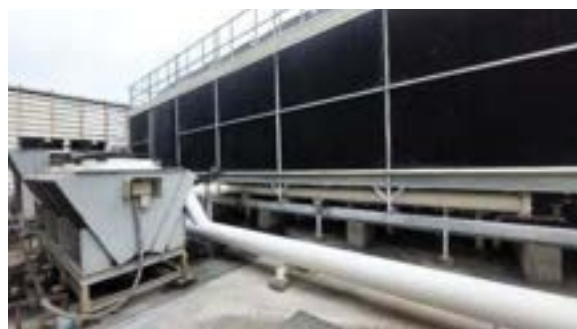
สภาพทั่วไปงานระบบอาคาร หอระบายน้ำเย็น (Cooling Tower)
