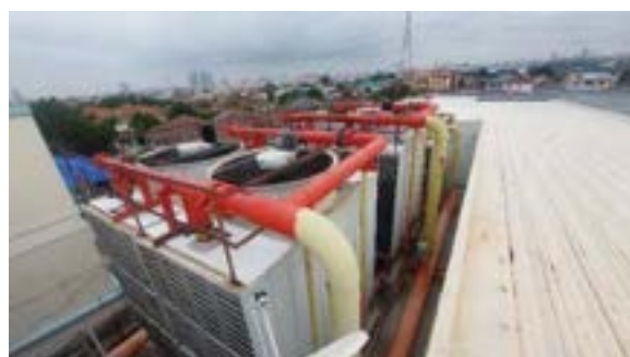
สภาพทั่วไปงานระบบอาคาร หอระบายน้ำเย็น (Cooling Tower)
