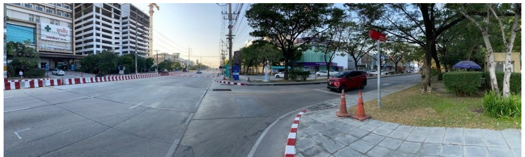
สภาพถนนนิคมอุตสาหกรรมอมตะซิตี้ แยกเข้าซอยพิศสุวรรณ
