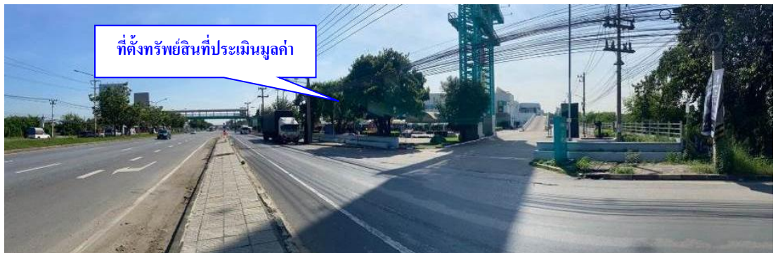
สภาพถนนบรมราชชนนี (ทล.338) บริเวณผ่านด้านหน้าทรัพย์สินที่ประเมินมูลค่า
