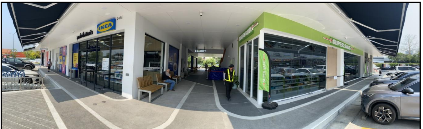
สภาพภายในอาคารชั้นล่าง / บริเวณพื้นที่ร้านค้า
