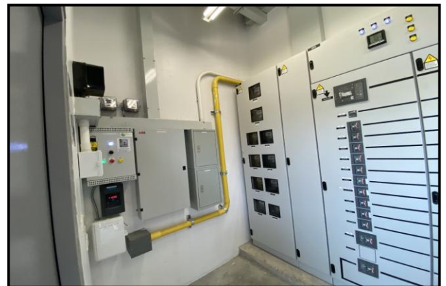
สภาพภายในอาคารชั้นล่าง / บริเวณห้องระบบไฟฟ้า
