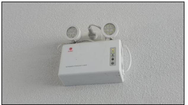
งานระบบ ไฟส่องสว่างฉุกเฉิน
