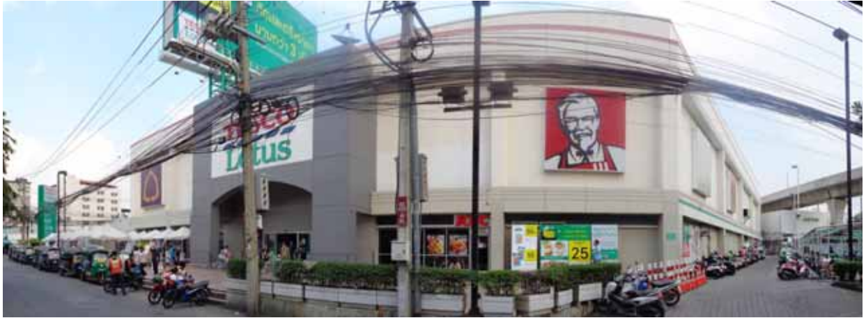
สภาพทั่วไปของอาคารเอสไอ โดดส์ ไฮเปอร์มาร์เก็ต สาขาประชาชื่น บริเวณภายนอกทรัพย์สินที่ประเมินมูลค่า
